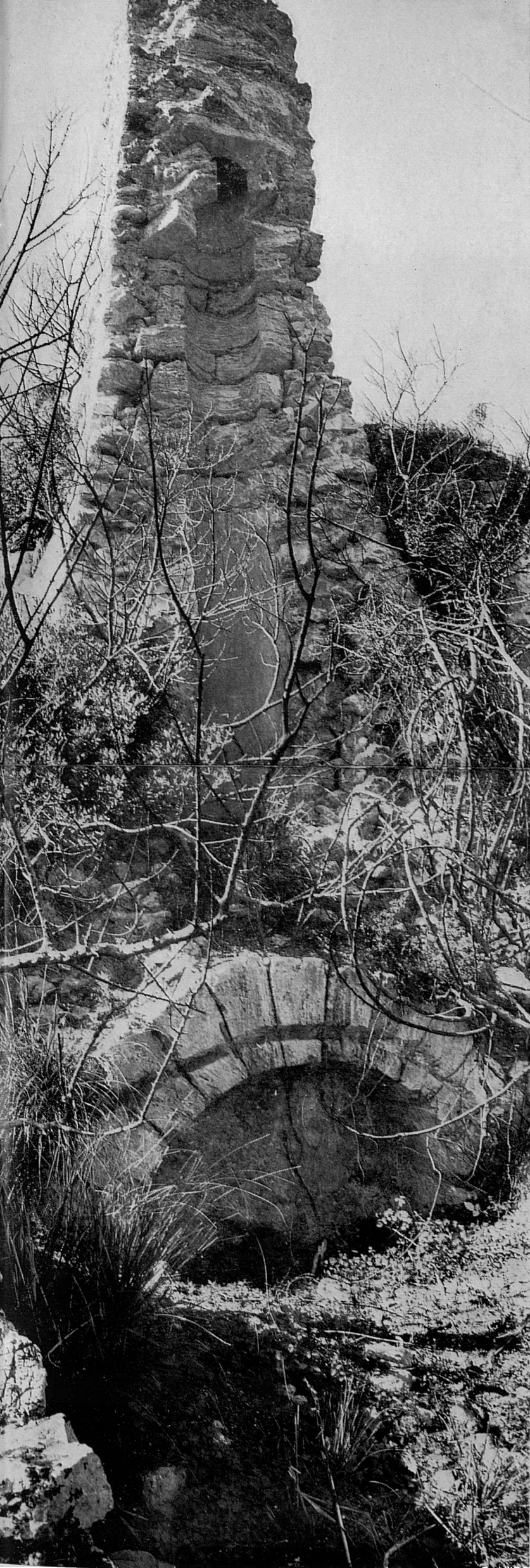
81. En aquest barranc, a mitja altura, hi ha les ruïnes d'un vell molí d'aigua, del qual encara es conserva en peu una paret de l'aqüeducte, rematat per un canó que té incrustat en salt vertical,
