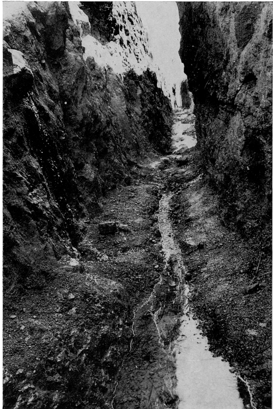
82. El molí era mogut per l'aigua de la Font de Son Morei, única existent en el lloc, que no n'és massa abundant. Ara, poc abans de passar-ne nosaltres, els amos cercaven de reanimar-la mitjançant una mina profunda, encara destapada, que haurà d'esser coberta amb la corresponent volta. La fotografia és presa de dins a fora de la mina i hi són de veure les exudacions aquoses de les parets.
