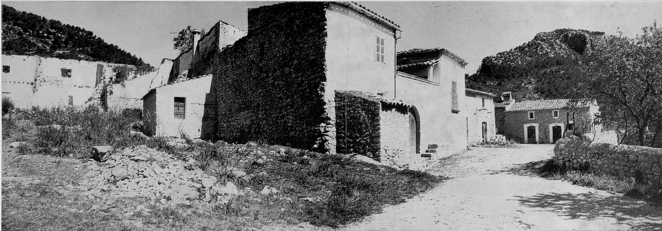
3. Ens trobam en la que en podríem dir la Plaça Major del poblet. Aquest està deshabitat, abandonat i en ruïnes. En aquesta foto...
