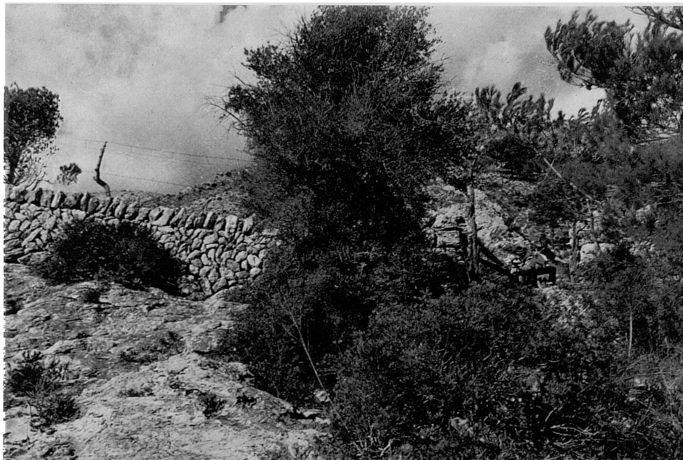
47. ...passant un altre portell en una nova paret partionera,...
