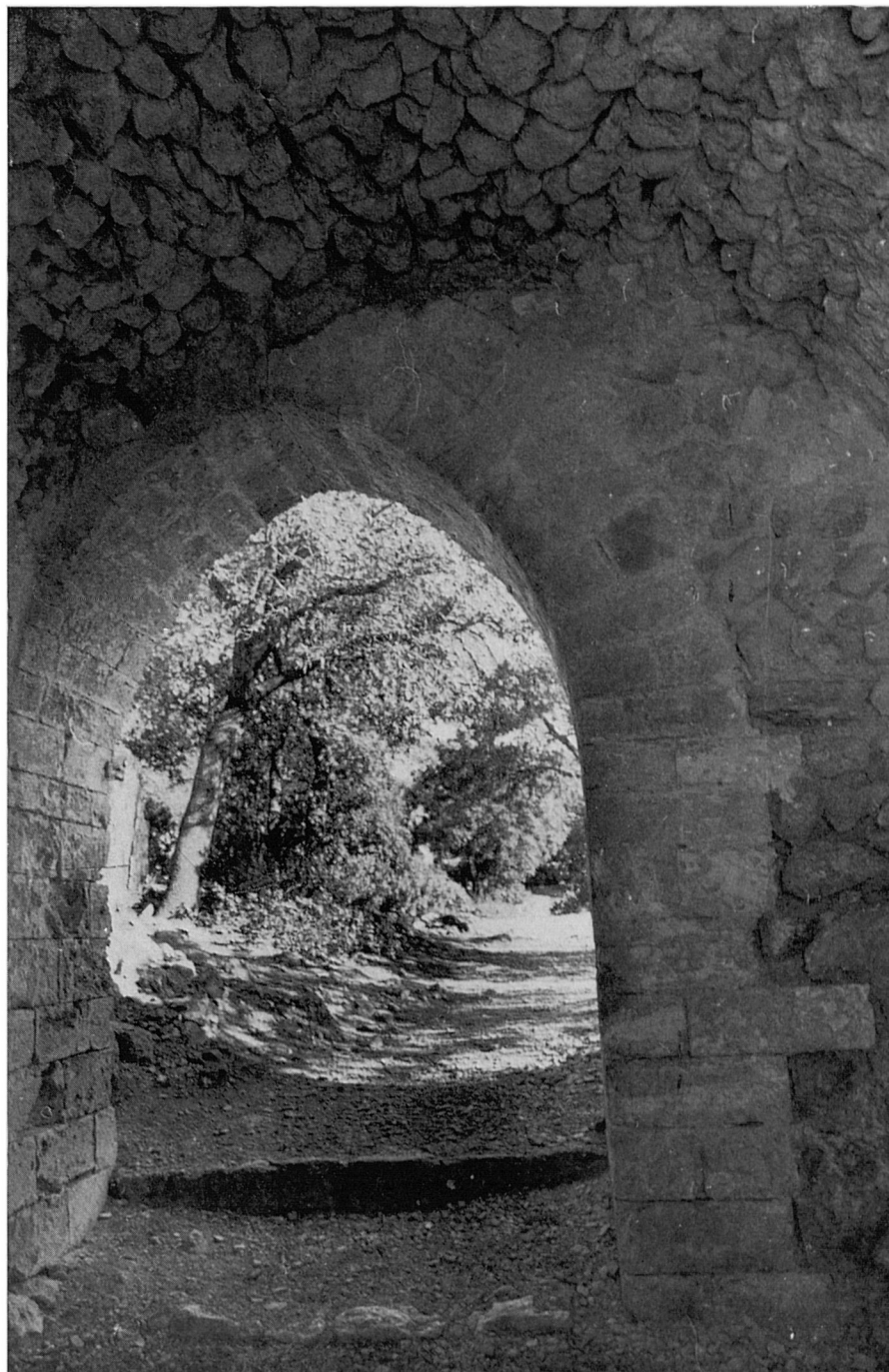
53. Passada la porta i el petit vestíbul que segueix, cobert amb falsa cúpula —sistema molt corrent en les construccions neotalaiòtiques barraques, aljubs i antres artificials de la ruralia mallorquina, fins a temps molt recents— s'arriba al cap d'amunt de tot del puig.
