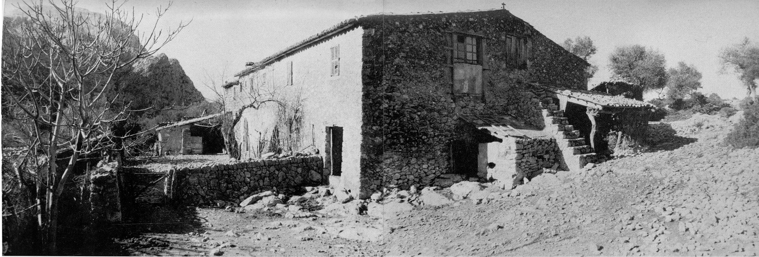
28. Les cases de Fartàritx des Racó —rústiques, humils i velles— són també una mostra en liquidació de construcció mallorquina en les llunyanes possessions de muntanya. La seva tosca i senzilla arquitectura i l'ambient solitari en paratge difícil d'antènyer, ens parla d'una vida sense pretensions, monòtona, senzilla i patriarcal, reduïda al mínim de les necessitats humanes, a on la principal i potser única meta és —o fou— “viure”.
