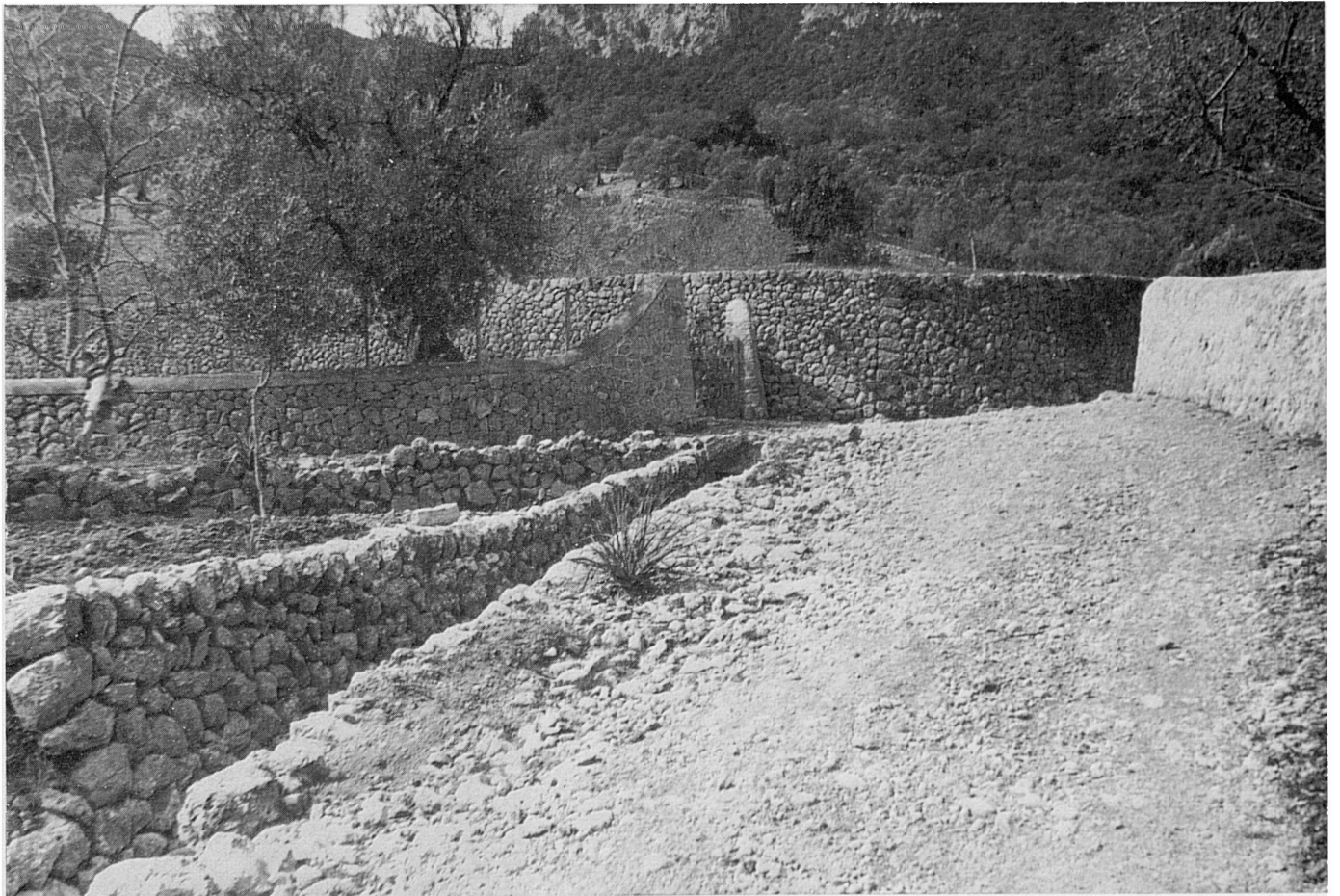
43. Poc més enllà de Son Malferit el camí enllaça amb la carretera que des d'Esporles puja a Sobremunt. Hem de tòrcer a l'esquerre. Aquest era un camí carreter de muntanya; fa poc ha estat millorat, eixamplant algunes revolts, i asfaltat pels promotors de la urbanització de Es Pouet de Sobremunt.
