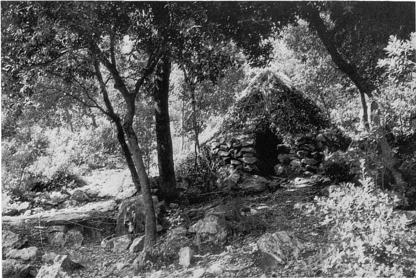
73. En la baixada d'aquest coster, cobert d'espès alzinar es troben moltes velles sitges, amb les seves barraques de carboner ja enrunades. Aquesta, molt més recent, conserva encara el sostre de branques...
