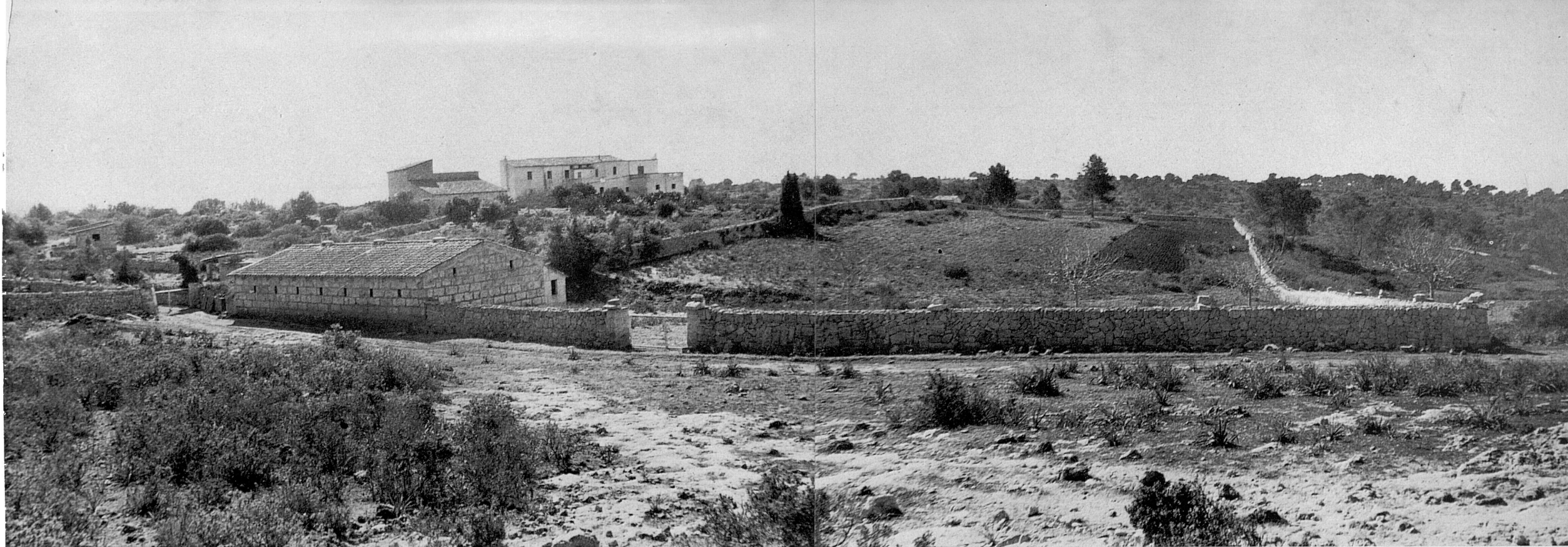
18. Des del mateix aljub prenim aquesta panoràmica a contrallum sobre les cases de Son Mendivil de Baix, edificació amb poca personalitat, utilitària i vulgar, feta amb mitjans de marès referits de blanc, material abundós en aquella zona.
