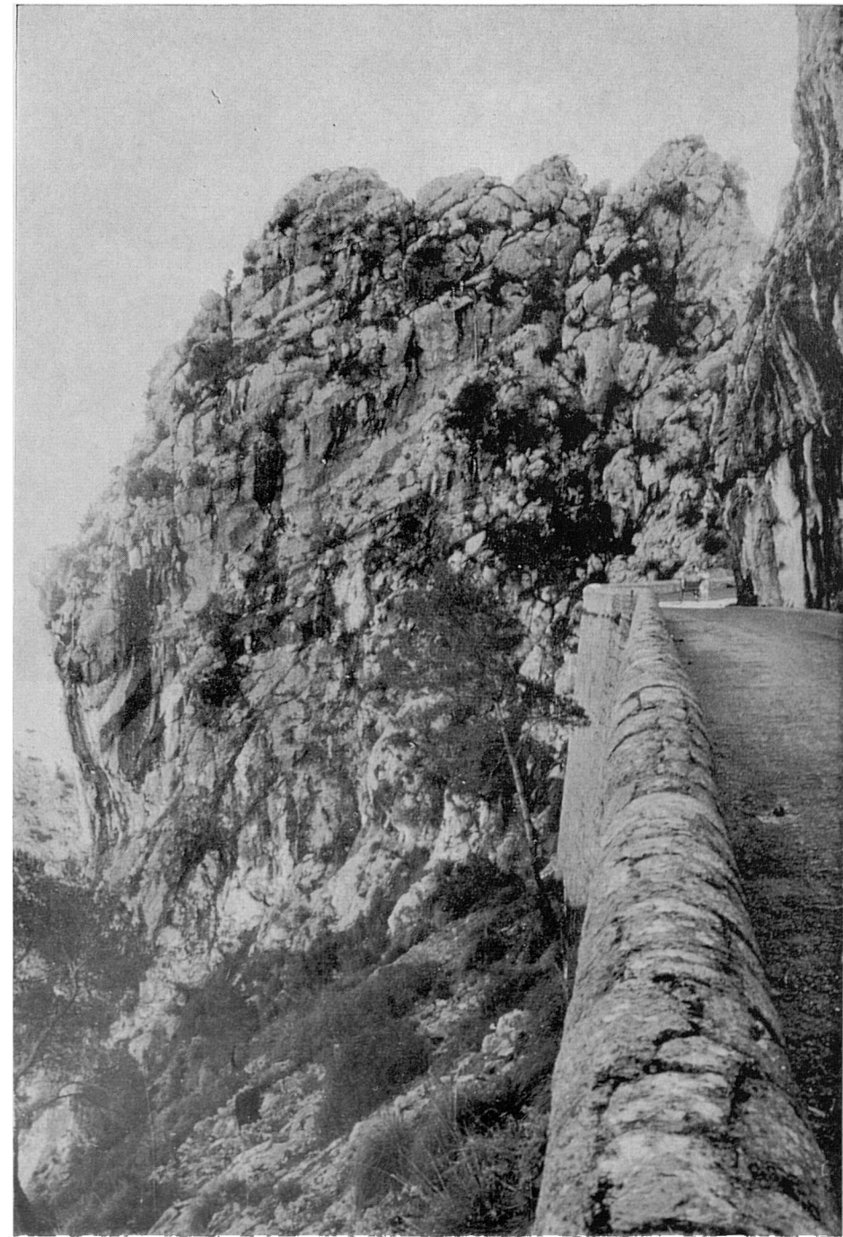
16. La carretera, al sortir de la bretxa, està sostinguda per un mur en talús sobre el llegendari precipici i allà mateix, vora el mur de contenció, es veuen encara restes del camí de ferradura que en passats segles —qui sap quants!— comunicava amb el pla aquests abruptes i desolats paratges.
