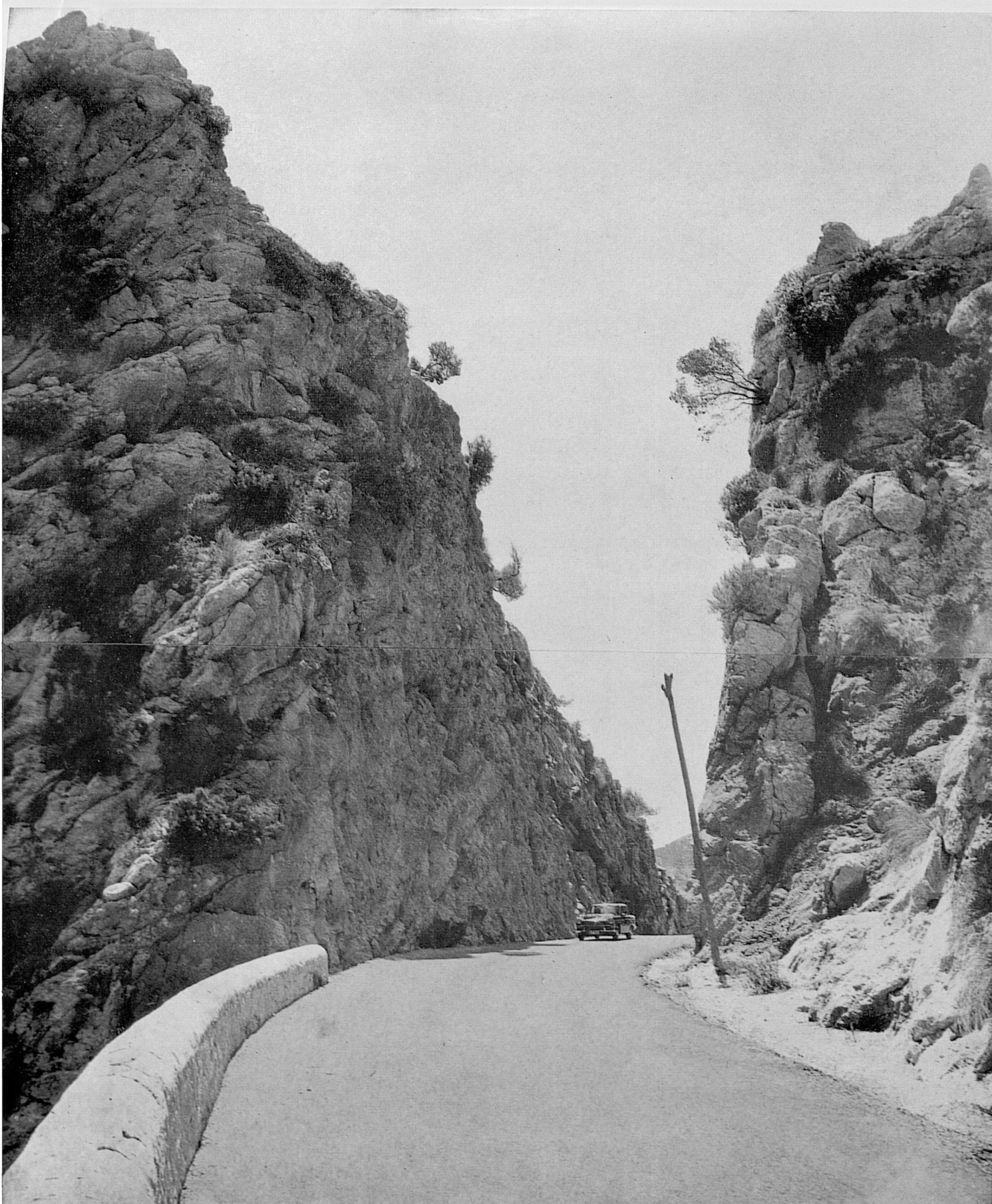
16. La carretera, al sortir de la bretxa, està sostinguda per un mur en talús sobre el llegendari precipici i allà mateix, vora el mur de contenció, es veuen encara restes del camí de ferradura que en passats segles —qui sap quants!— comunicava amb el pla aquests abruptes i desolats paratges.
