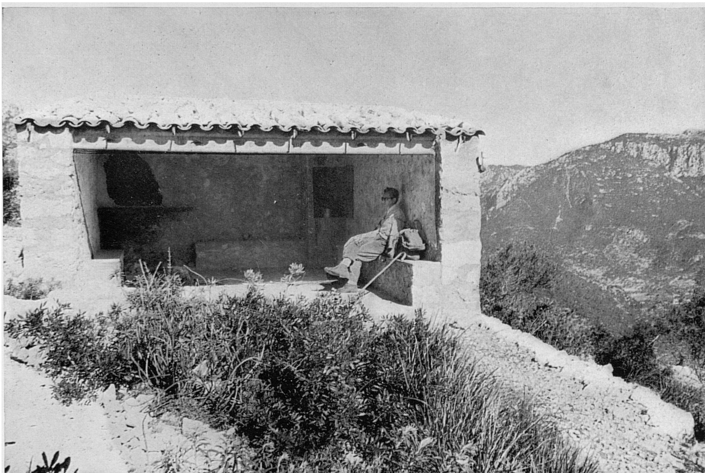
71. El sobri refugi de Sa Gubia té un fogar i una cisterna que recollia l'aigua del terrat per una canal avui desapareguda. Malauradament, la inclemència del temps, que pega fort en aquella indefensa i descoberta altura, i, el que és pitjor, l'assot de certs incivils i —a la seva manera— alegres excursionistes, que solen agermanar la “seva” alegria amb la destrucció, han contribuït a deteriorar sèriament i a embrutar les intallacions.
