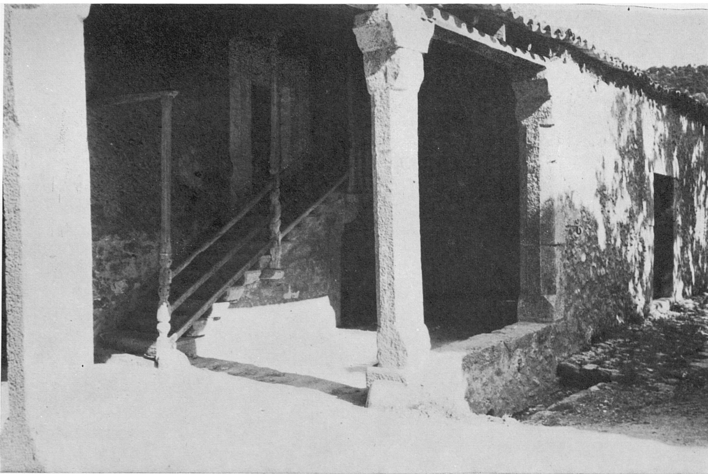
45. ...l'arrencada de l'escala que dóna accés a la galeria...
