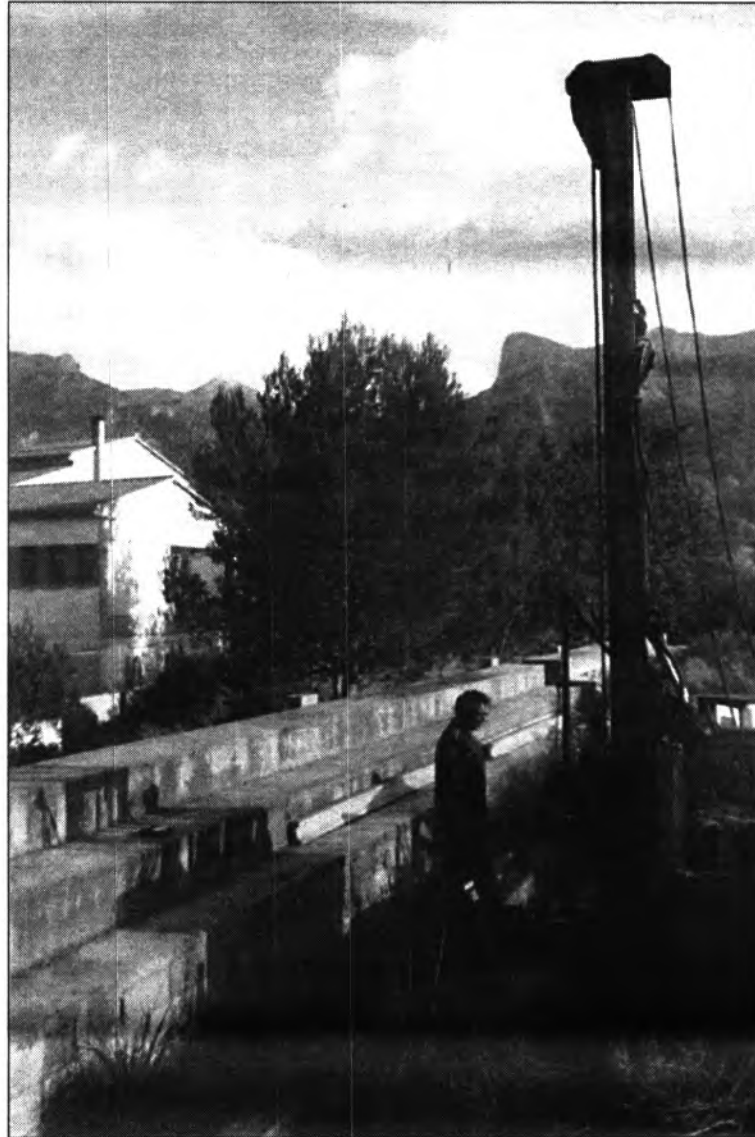
Els sondejos revelen que el subsòl és prou consistent per suportar la coberta del poliesportiu.
