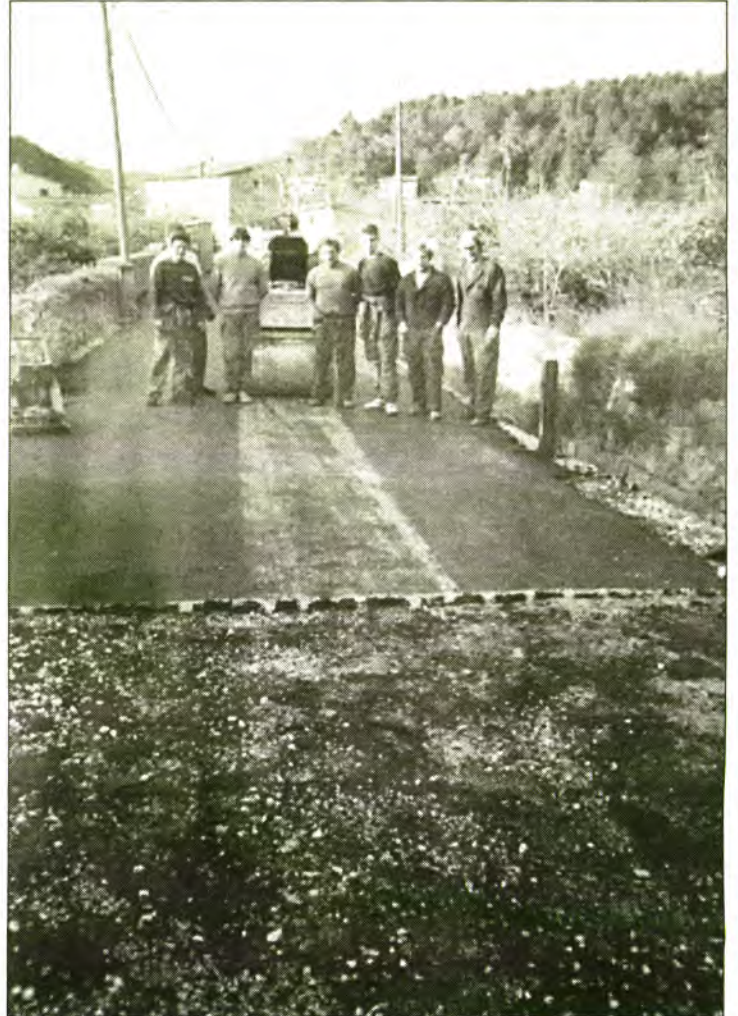
Des del mes de setembre els veïns esperaven les màquines, però el temps humit no permet una correcta aplicació de la capa asfàltica. A la foto, els obrers de l'empresa Aglomsa que participaren en els treballs d'asfaltat.
