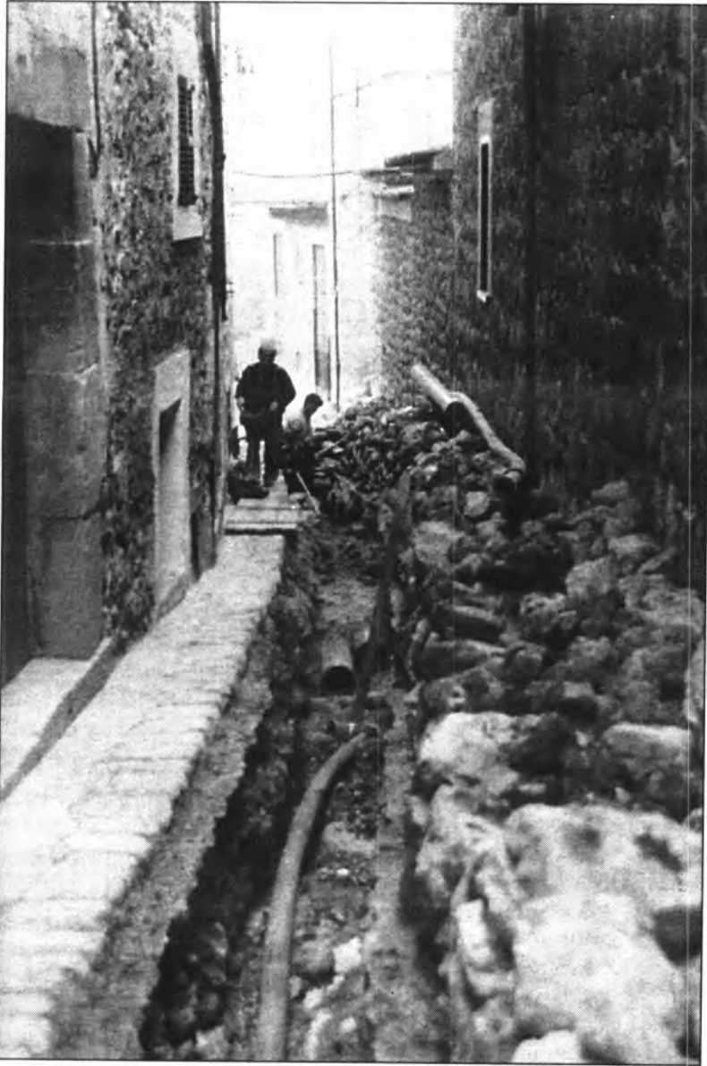
A cada un dels carrers que s'obren s'hi instal·la una canonada per a les aigües residuals, una altra per a les aigües de pluja i una tercera per a l'aigua potable.
