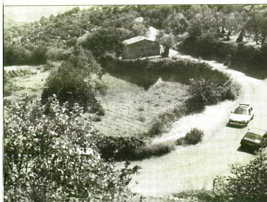
Les corbes que es veuen el fons seran eliminades i la carretera serà recta. L'hort de Can Prohom serà afectat mínimament perquè la calçada serà amplada fins a 7 metres.
