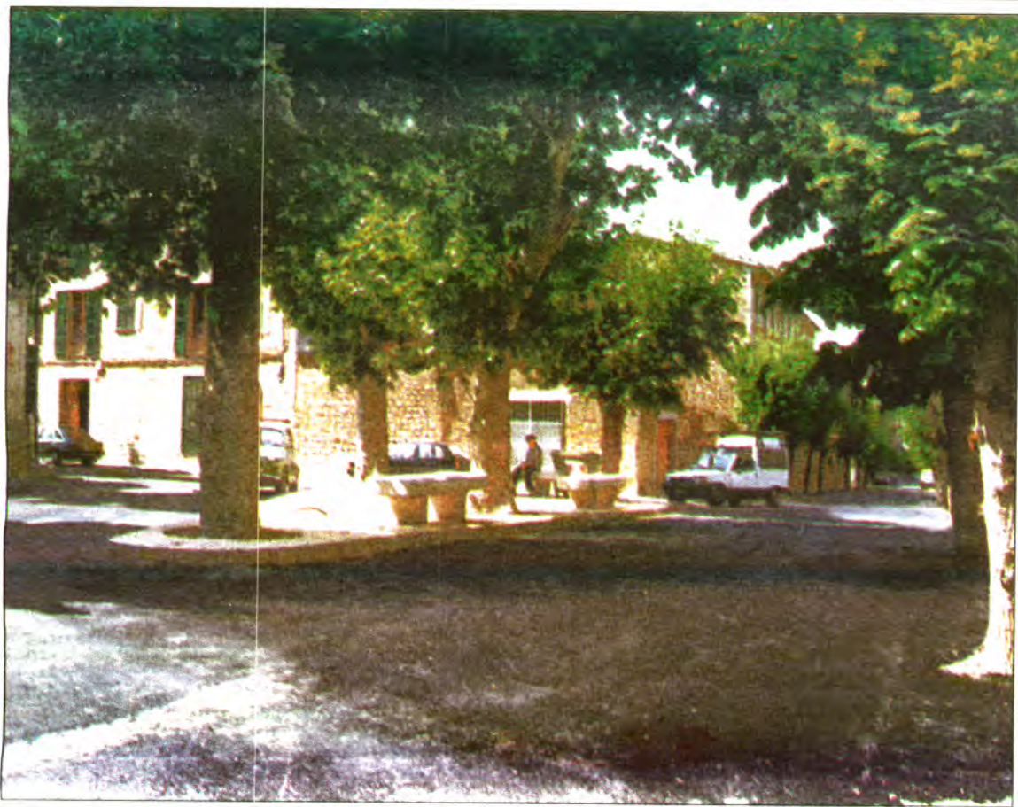
La Plaça dels Estiradors, el Carrer de Santa Teresa i altres han estat asfaltats després d'instal·lar les xarxes de clavegueram, aigua potable i aigües pluvials.
