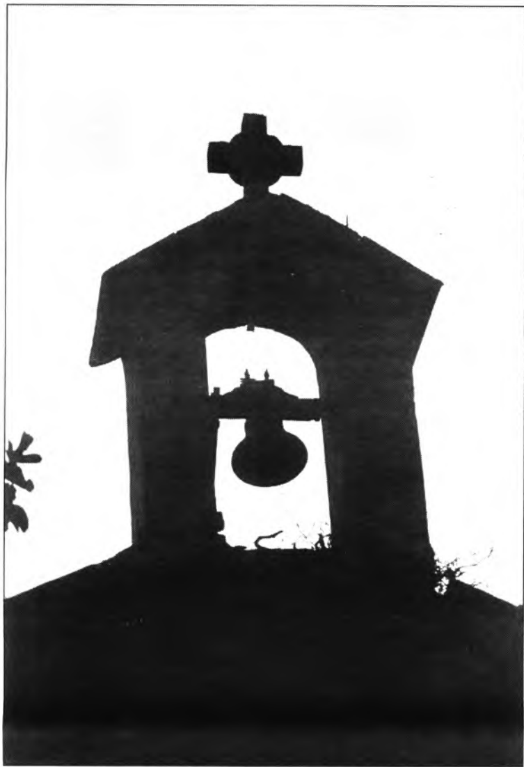
L'horatori de Castelló necessita reparació urgent
