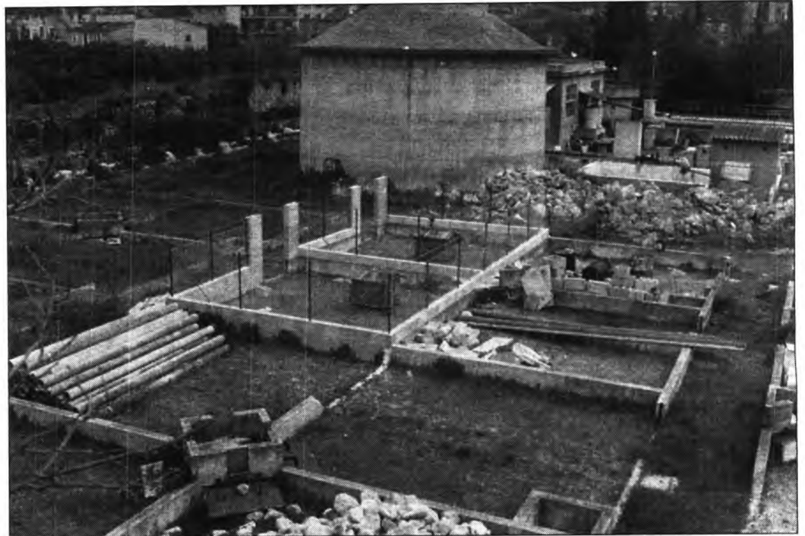
La brigada d'obres les ha construït i no sols s'utilitzaran per acollir cans sinó també altres animals que es puguin trobar a la via pública.
