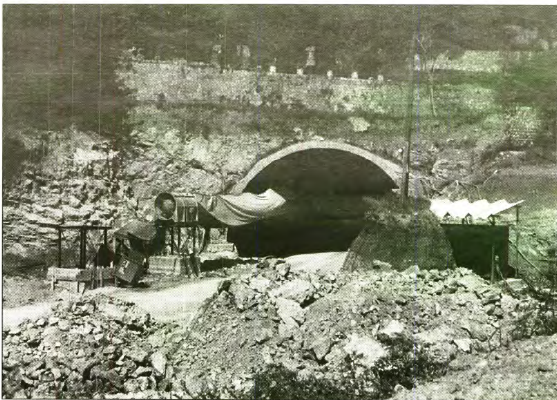
A la banda de Bunyola les obres avancen molt més aviat que a la boca de Sóller.
