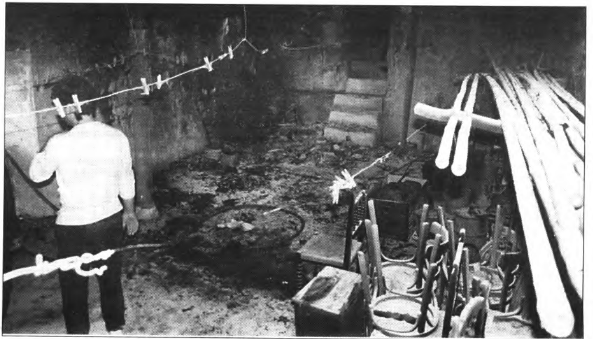
Estat en què quedà l'habitació on s'originà l'incendi just després de la intervenció dels bombers i la policia.
