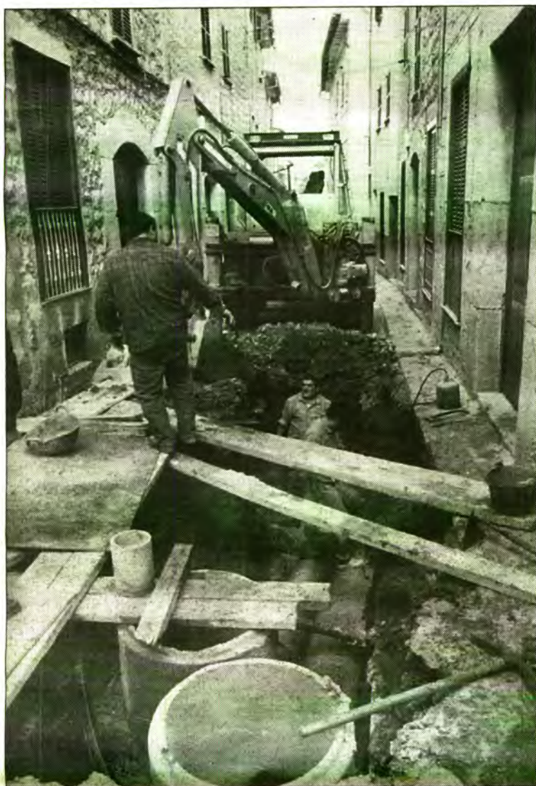
A cada domicili particular se li canvia la presa d'aigua potable i la sortida d'aigües residuals.
