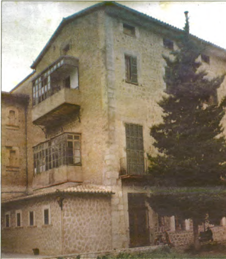
Aquesta mateixa setmana quedaran llestes les obres d'ampliació del Centre Sanitari
