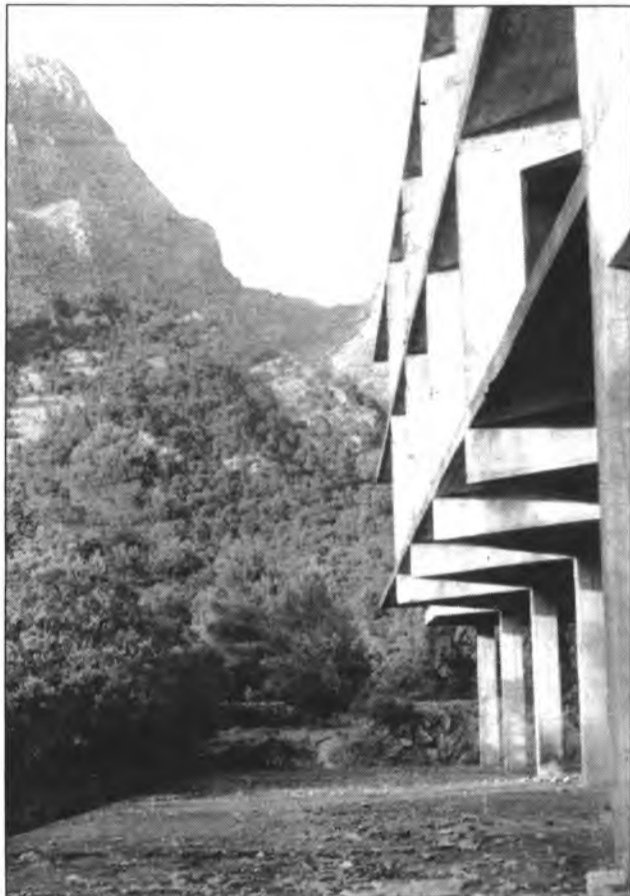
L'hotel es començà a construir a principis dels anys seixanta i mai no passà de l'estructura. Legalment, és un indocumentat.
