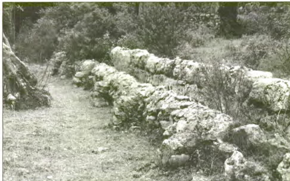
La síquia primitiva, avui abandonada, estava feta amb pedra i argamassa i, en alguns indrets, era reforçada amb petits contraforts.
