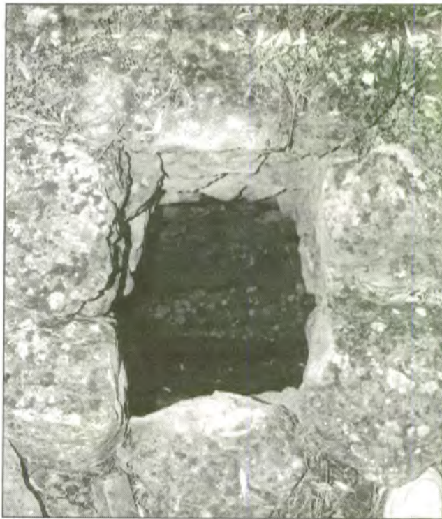
Adesiara, la coberta de volta té uns pous de registre per controlar la síquia que corre al fons.
