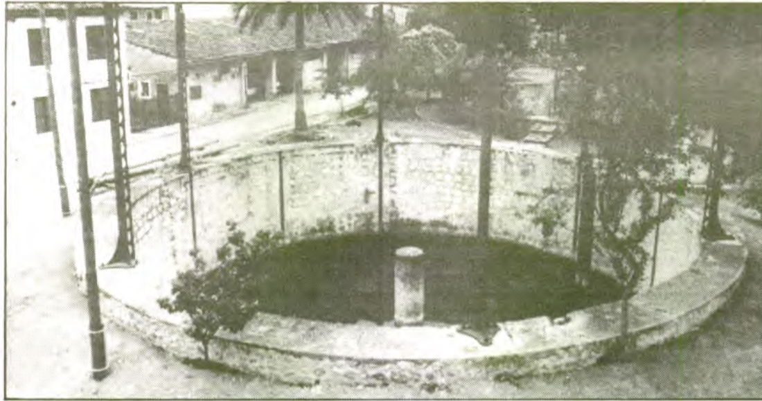
Encara queden restes del gasòmetre on s'emmagatzemava el gas ciutat: dos grans safarejos plens d'aigua que es cobrien amb una campana de ferro. Entre la campana i l'aigua s'hi acumulava el gas abans de ser distribuït.
