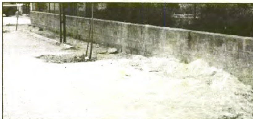
El munt d'arena de la fotografia encara és al carrer. Són restes de les obres de Biniaraix.
