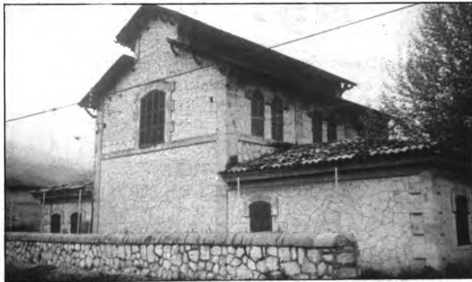
L'escorxador municipal és un bell edifici modernista construït als voltants del 1920, que precisa algunes reformes.
