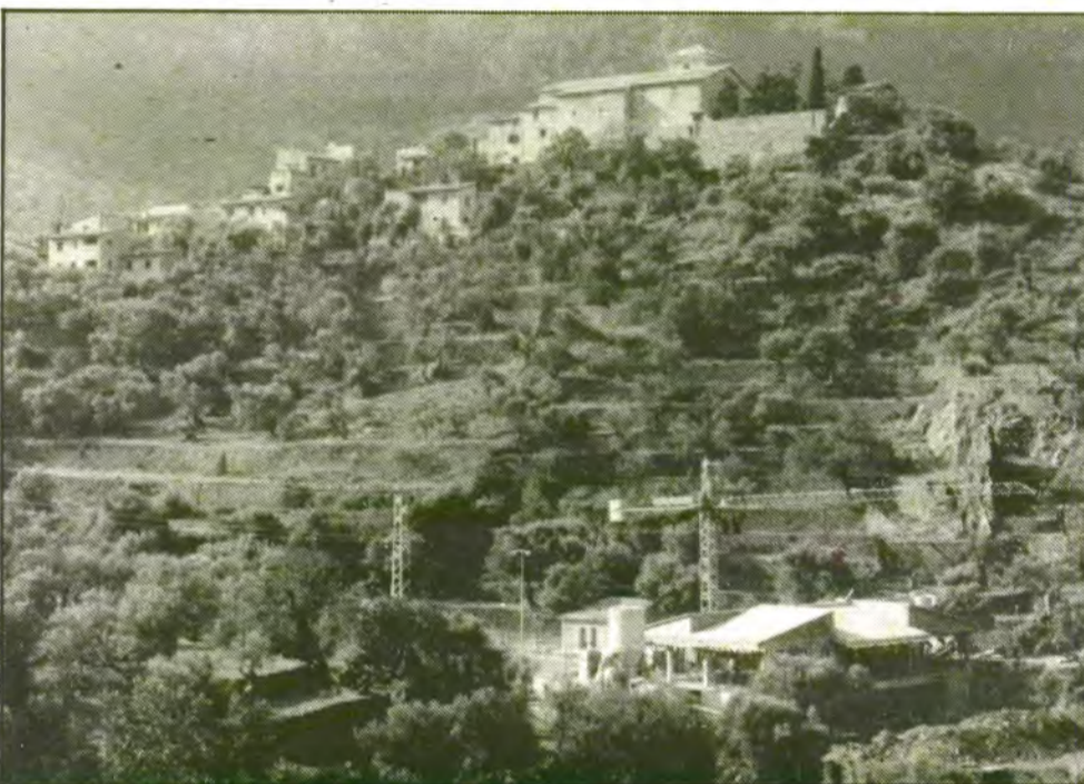
L'edifici de l'escola d'E.G.B. està situat a la mateixa altura que la pista poliesportiva.
