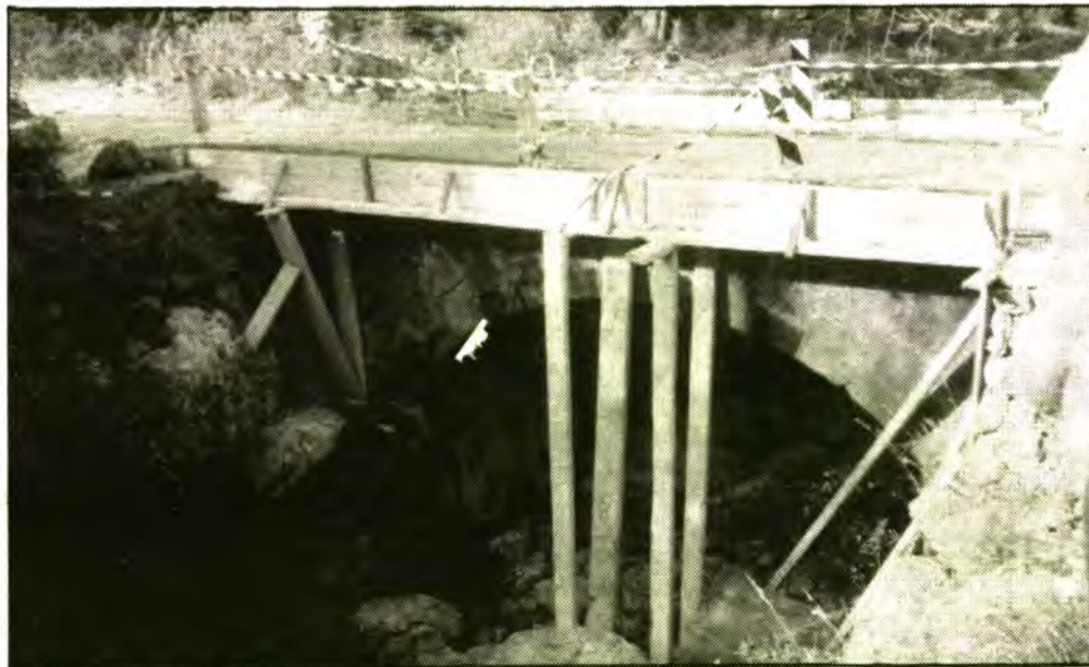
La volta de marès del pont està cruiada d'antic, però els propietaris de terres dels voltants segueixen passant ben tranquil·lament amb els seus vehicles.
