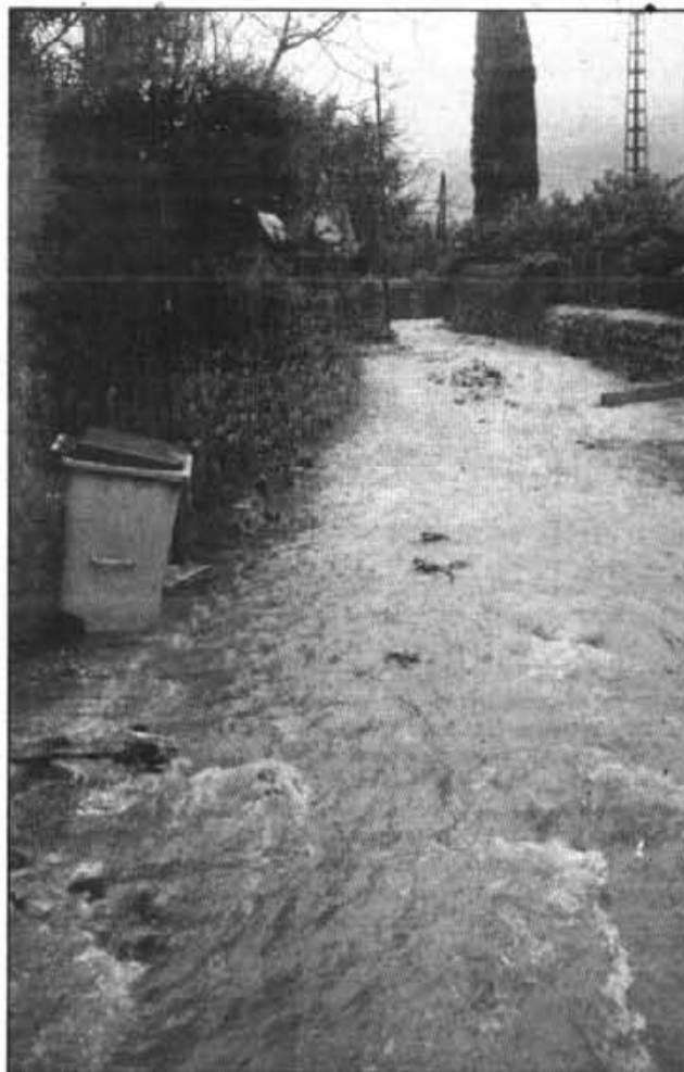
El torrentó de Can Creueta, que coincideix parcialment amb el camí, ha sofert greus desperfectes.
