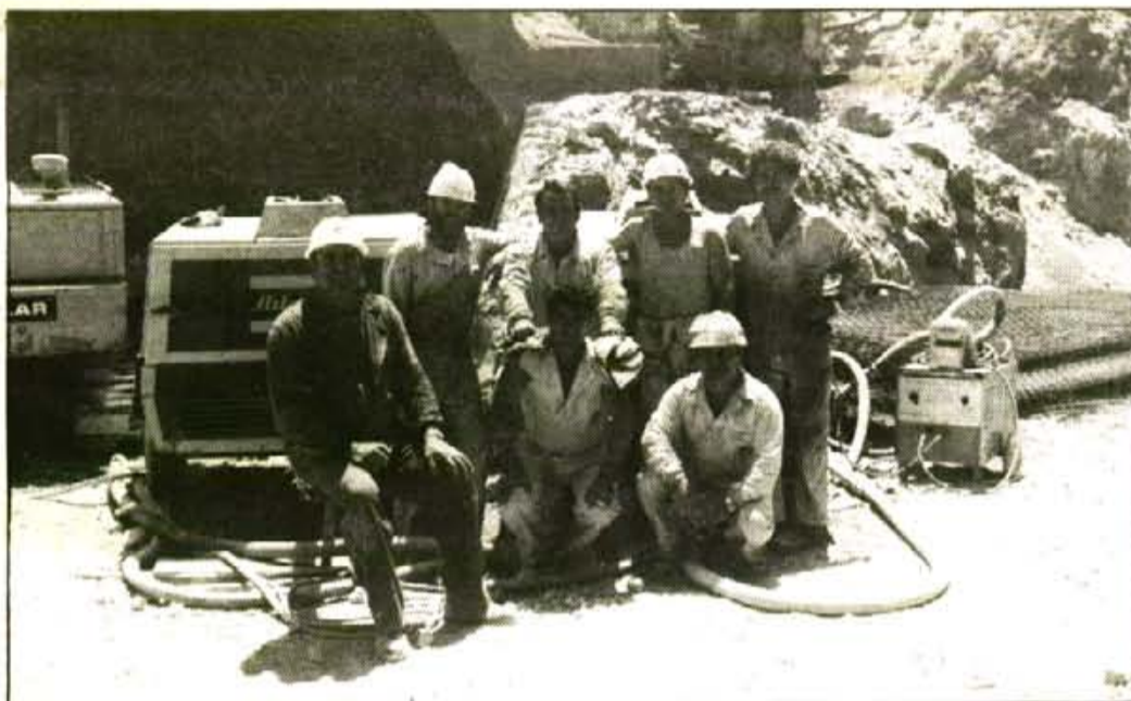
El túnel tindrà 3 Km. de llargària, 8 metres d'altura i 11 d'ample.
