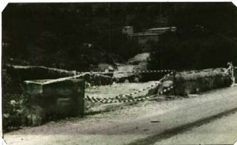
A la banda esquerra s'ha començat una nova desviació. Serà el nou traçat de la carretera actual. S'eliminen així els dos primers revolts.
