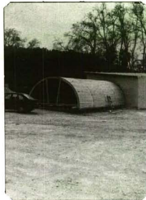
Ja està preparat l'encofrat del pontarró que salvarà el torrent. Encara no és l'encofrat del túnel.
