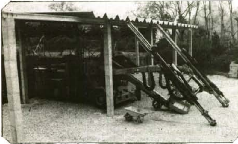
Aquesta màquina forada la pedra per col·locar els barrobins. És la curiositat i l'estrella de les obres.
