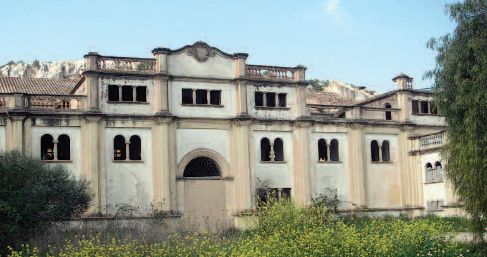
Aquesta emblemàtica edificació va ser declarada Bé d'Interès Cultural amb la categoria de monument.
