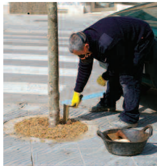
S'ha instal·lat un paviment drenant que permet el pas de l'aigua i de l'aire
