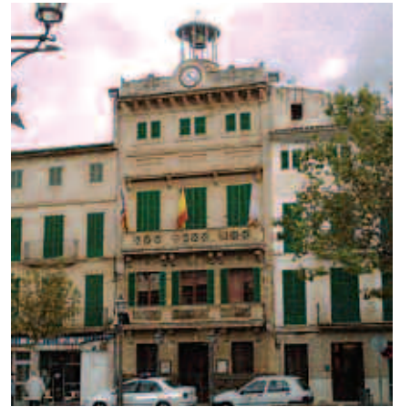
La casa de la vila i alguns edificis dels voltants han estat declarats com a part del patrimoni
