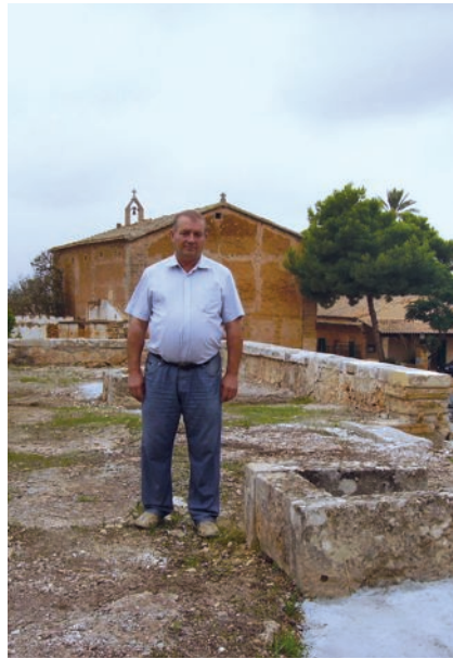
El constructor Miquel Valls està duent a terme les obres de restauració.
