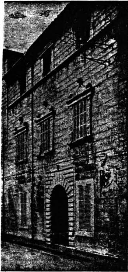
Segons el projecte del PSOE, aquest edifici, ha de demolir-se, per donar lloc a l'obertura del carrer
