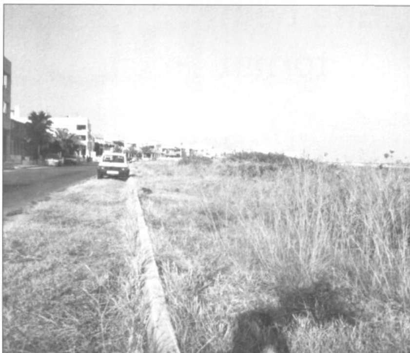
— L'estat actual de la primera línia és deplorable i impropri
