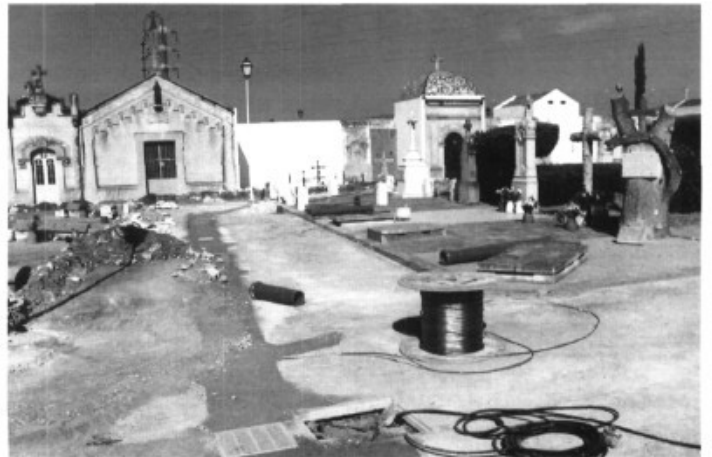
Les recents obres d'electrificació i pluvials
