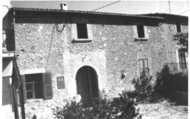
Un exemple de reforma ben aconseguida. Can Roca, de Pòrtol
