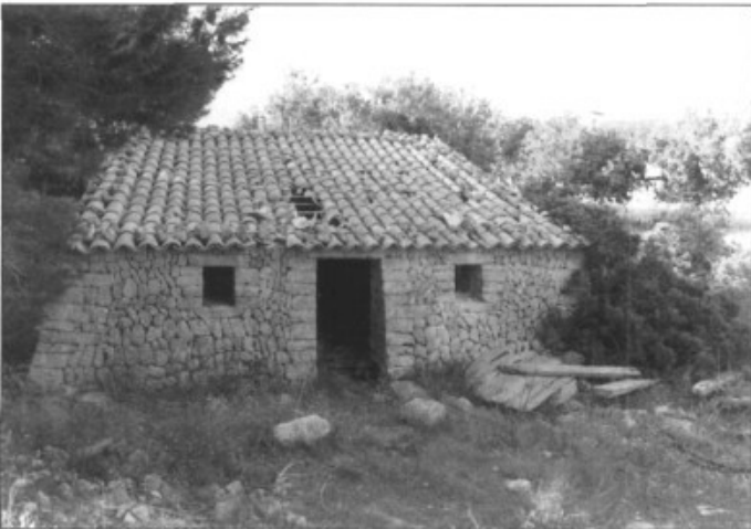
Les porqueres de Son Caulelles, construcció en pedra seca que just abans d'integrar-se al catàleg d'elements protegits s'ha convertit en història.
