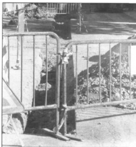
Ja han acabat les obres de clavegueram del camí de Muntanya al seu pas pel carrer Weyler
