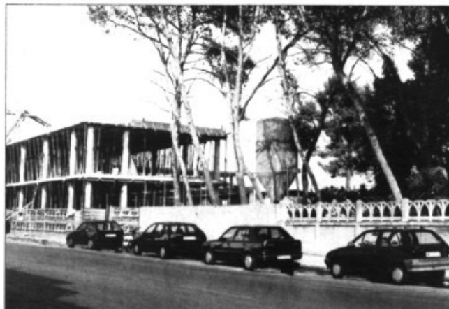
Les obres d'ampliació del col·legi
