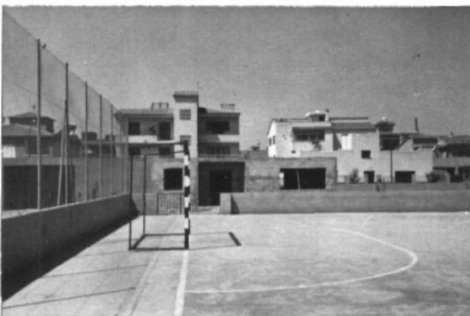
OBRES DE MILLORA AL POLIESPORTIU DE SA CABANA
