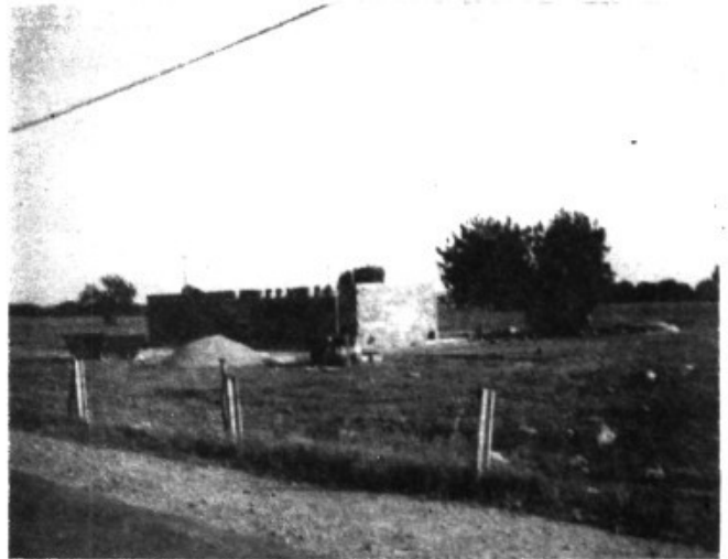
Les obres del nou cementeri ja estan en marxa...
