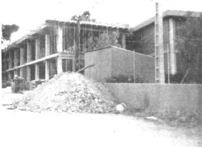
"COSTA I LLOBERA" ACABADES LES OBRES D'AMPLIACIO.
