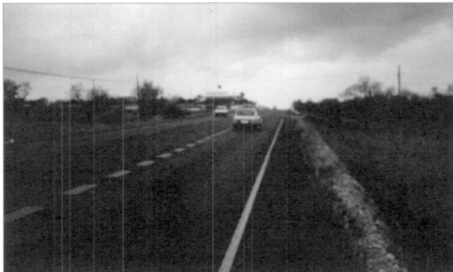
Cambio de rasante del Baviera: En esta zona de la carretera se necesita con urgencia una rotonda, señalización de los accesos, anuncio de la peligrosidad de los cruces sin visibilidad, reducción de velocidad, etc.
