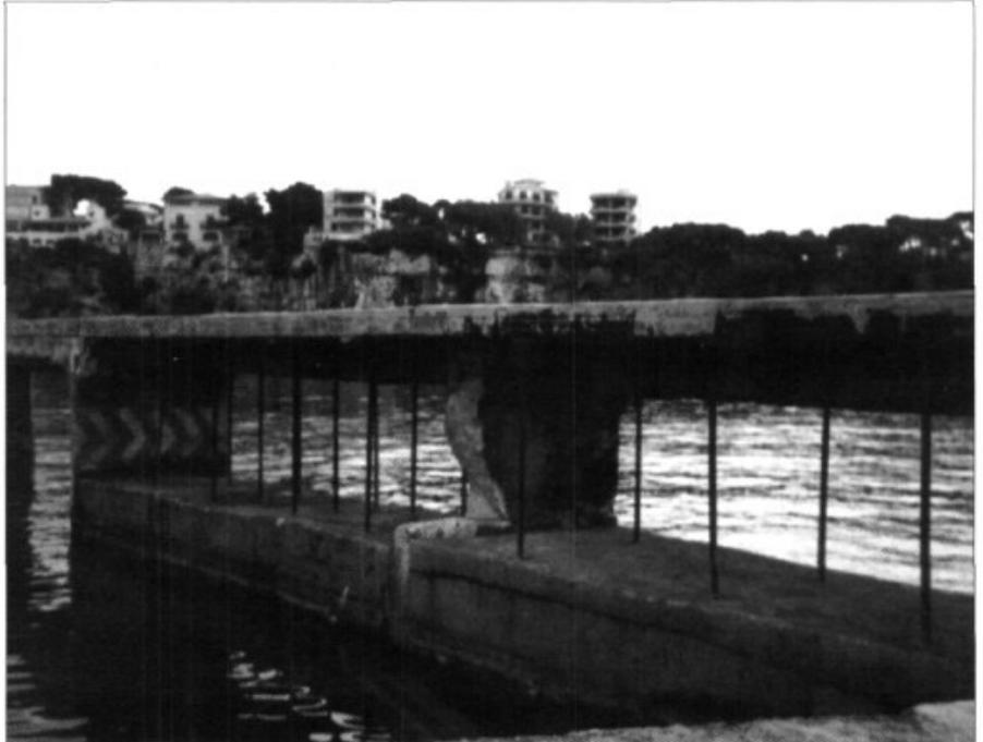
*Los técnicos han instalado en los ojos del gran espigón varios soportes mientras se realiza el encofrado.*
