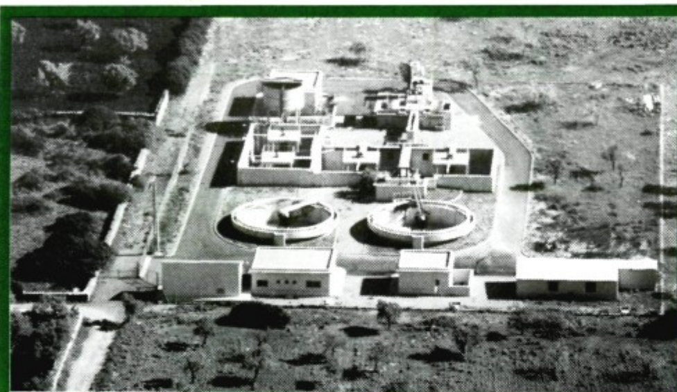
Ésta es la nueva Depuradora de Porto Cristo y S'Illot
