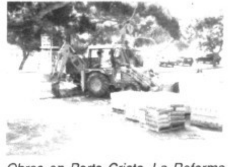
Obras en Porto Cristo. La Reforma circulatoria, verá mejorada la circulación de nuestro pueblo.
