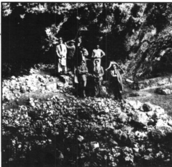
Socavón dels Hams, durante las obras para la inauguración en 1.910
