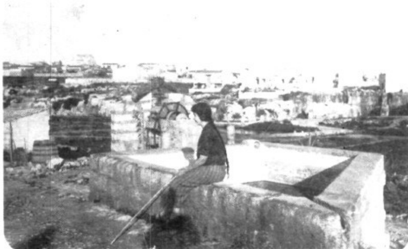
Francisca Servera (E.P.D.), aquesta senyora, «Sa Caminera» despachava es pesatjes de sa camiona an as carrer major. Orientació d'aquest retrato: sa segona casa de la dreta es Ca'n Biel Gasparoto. 1928.
