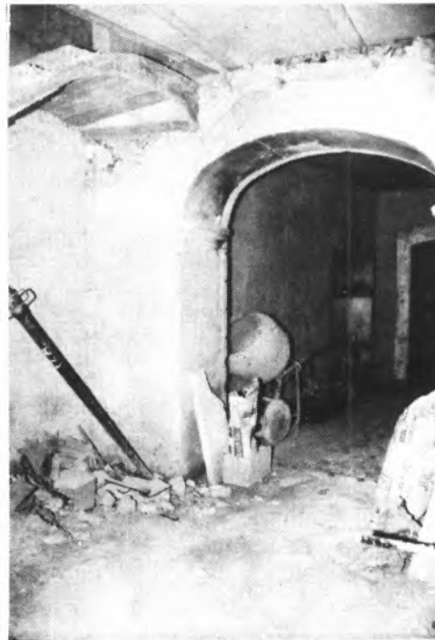
— Ha podido conservarse el arco de unión entre las dos primeras dependencias del local.
