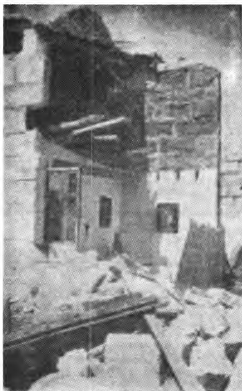
Ruinas de una casa de Manacor, derribada durante un bombardeo aéreo cuando la campaña del 36. Estuvo situada al comienzo de Calle Condesa, junto a la Avenida de Es Torrent.
